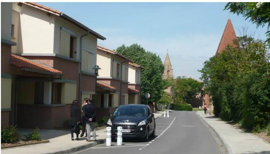
Exemple de maisons de ville ou logements intermédiaires avec une architecture en harmonie avec le noyau villageois (Emploi de matériaux traditionnels locaux).
