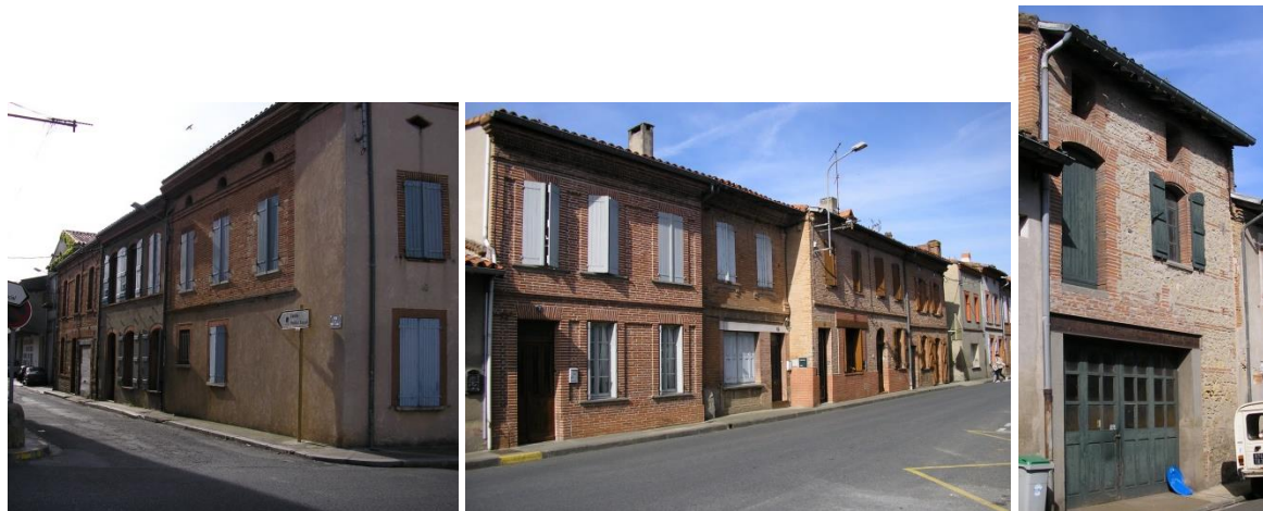
Constructions du centre bourg de Bazège pouvant servir de référence pour la réalisation des nouvelles constructions (Toiture, rythme des façades, ouvertures, couleurs, matériaux, ...)
