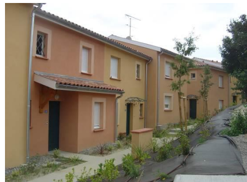
Exemple de maison de ville qui reprend les codes des constructions du centre bourg (mitoyenneté, composition et rythme des façades, couleurs,....)
