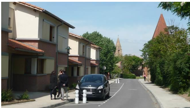
Exemple de maisons de ville ou logements intermédiaires, en harmonie avec le noyau villageois par l'emploi de matériaux traditionnels locaux..
